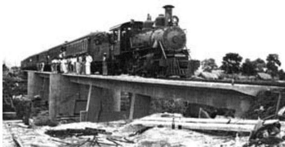
Trem especial de inspeção sobre uma das novas pontes de concreto no trecho do Pantanal de Mato Grosso, na década de 1940 (acervo RFFSA)
